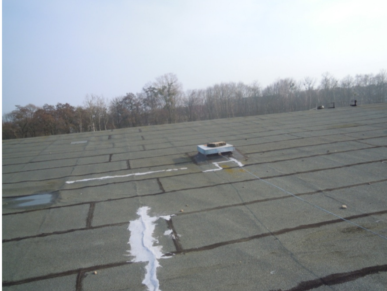
Nierówności i pofalowania połaci dachowej.
