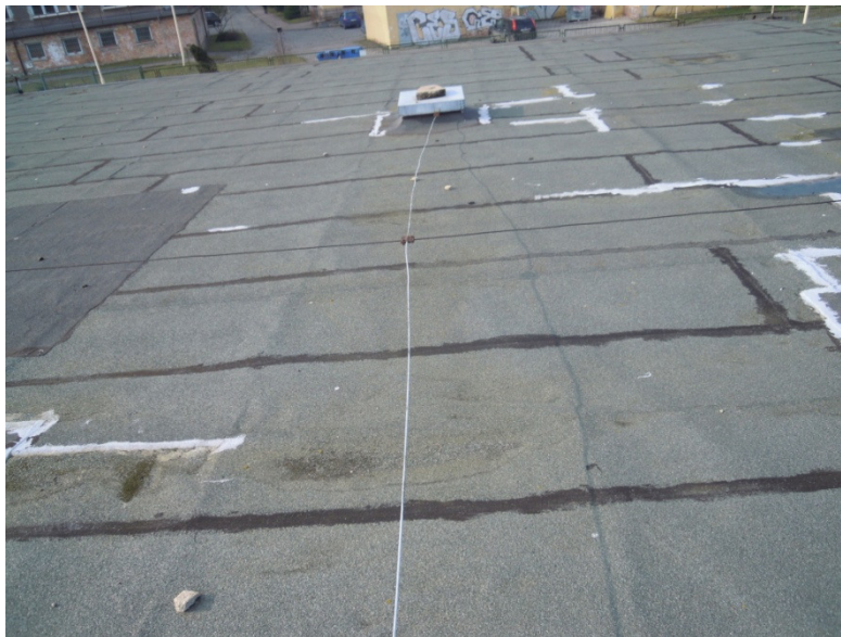
Liczne naprawy pokrycia dachowego.
