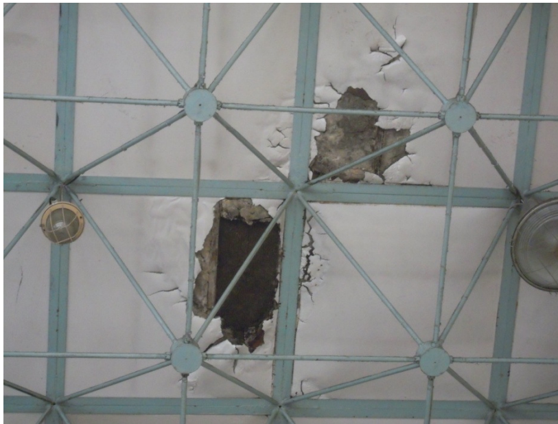
Uszkodzona płyta pilśniowa od wnętrza hali.
