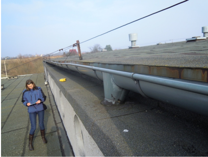
Rynny i obróbki blacharskie kwalifikują się do wymiany.
