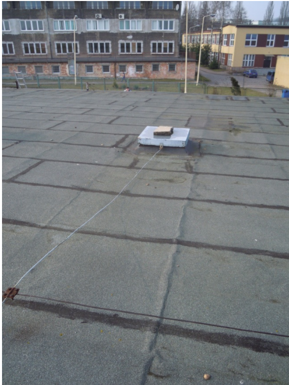
Spękania papy w skutek podatności na uginanie się podłoża.
