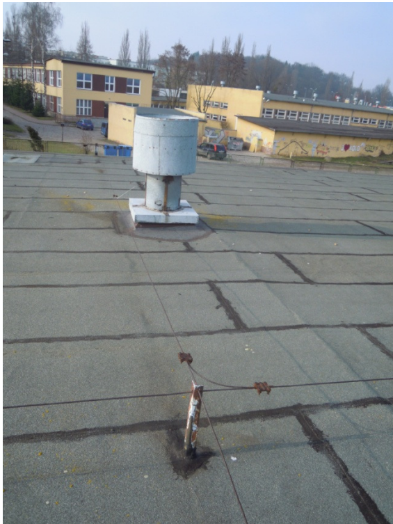
Instalacja odgromowa do wymiany.
